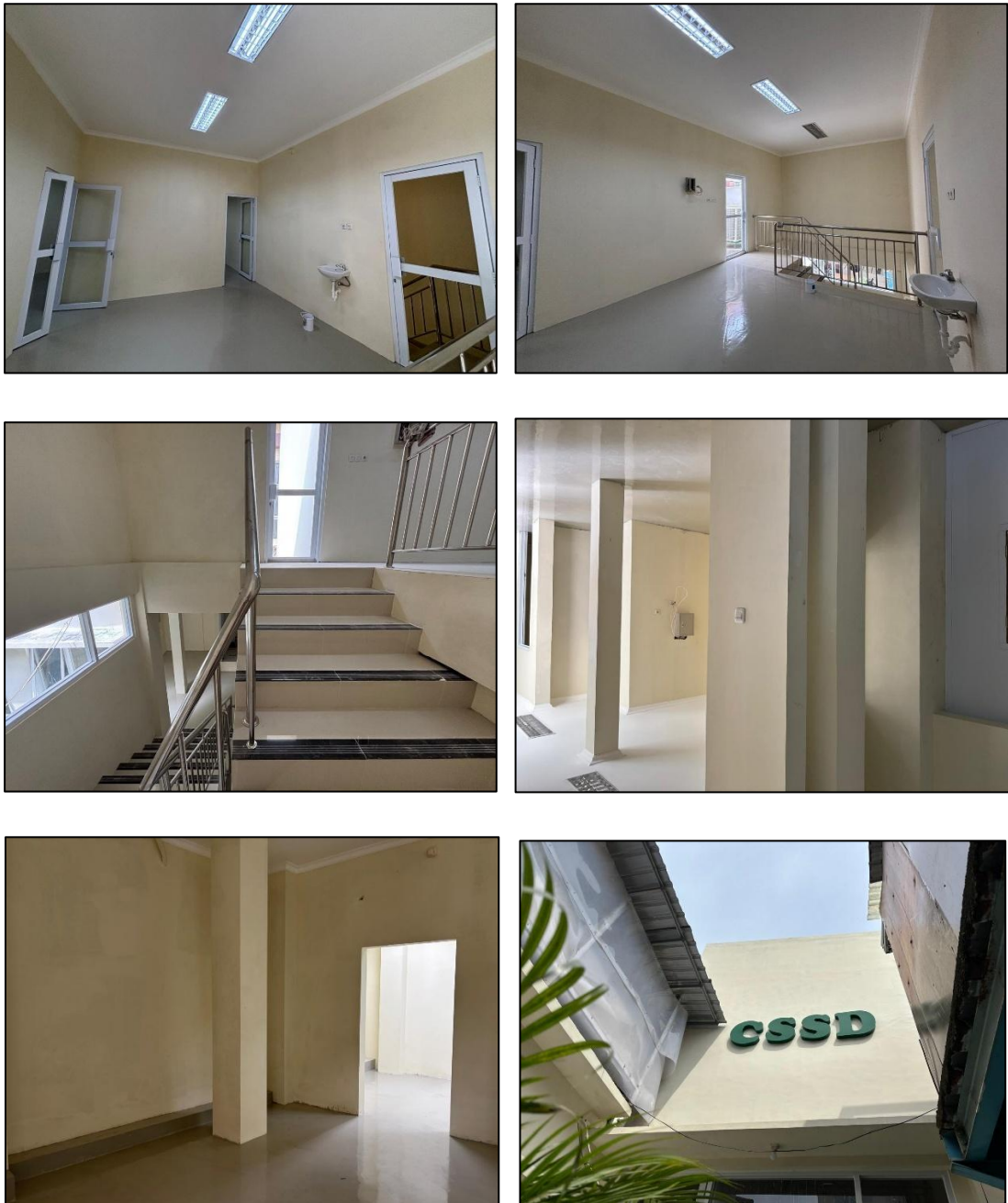
Gambar 5 Rahabilitasi Ruang CSSD
