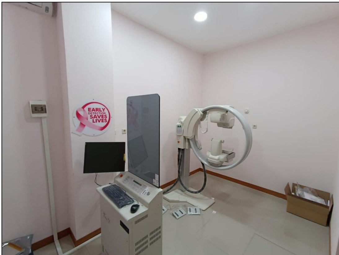
Gambar 8 Rehabilitasi Ruang Mamografi
